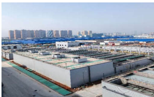
黄花园区新建三期废水处理站
