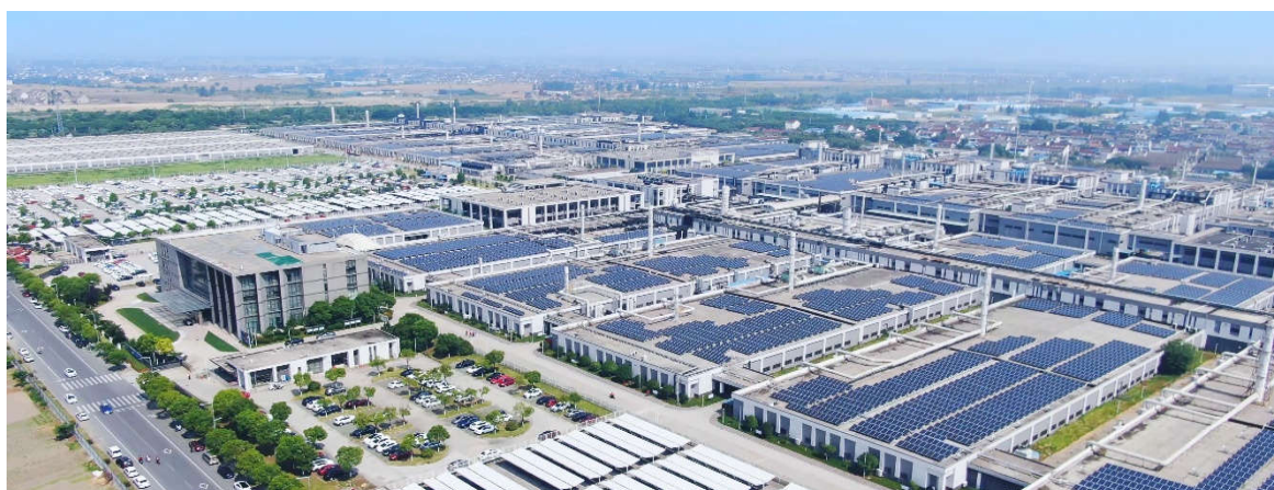
泰州园区屋顶太阳能
